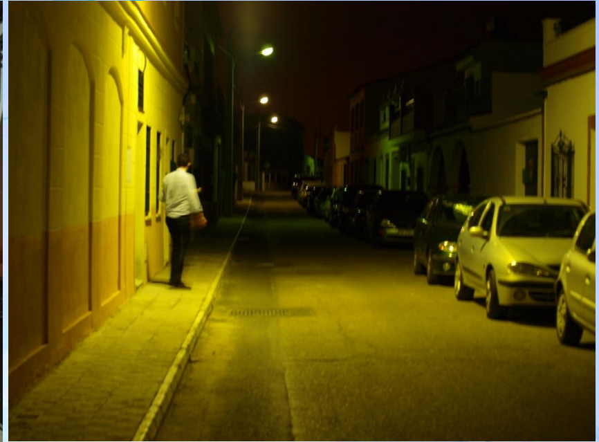
Luminarias Vapor de Mercurio
