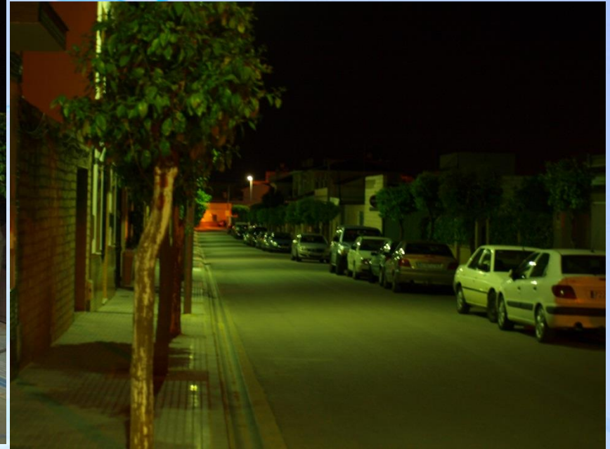
Luminarias Vapor de Mercurio
